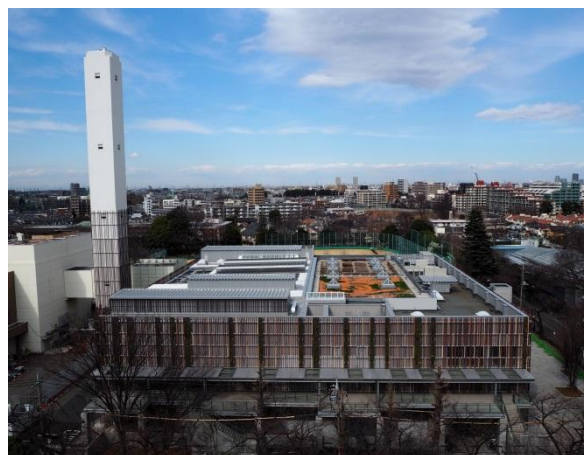
平成29年4月撮影（工場棟完成）
