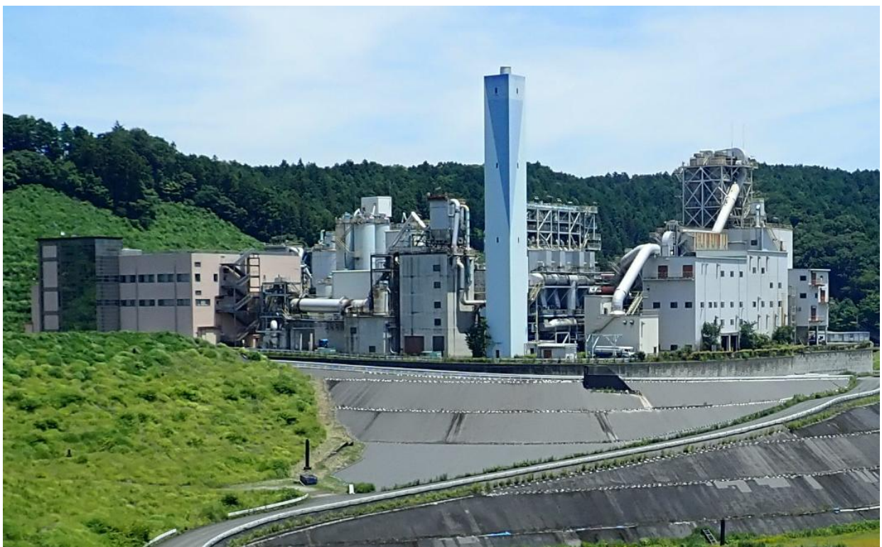
エコセメント化施設の全景
