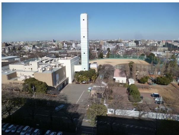
平成26年1月撮影（着工前）
