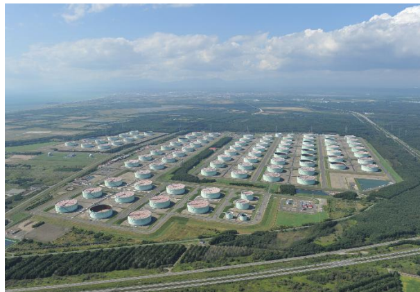
苫小牧東部国家石油備蓄基地（地上）
