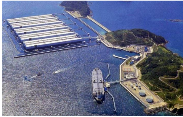
上五島国家石油備蓄基地（洋上）
