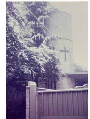
3階(増築)があった頃の東側外観 (ノートルダム清心女子大学所蔵写真)
