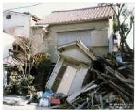
建築物の倒壊による道路閉塞の様子
