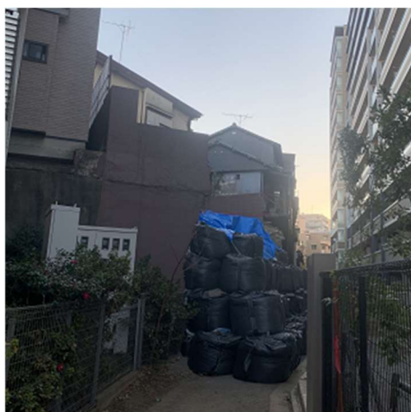
杉並区の擁壁倒壊事故（応急措置後）
