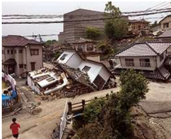
熊本地震による建物倒壊事例
