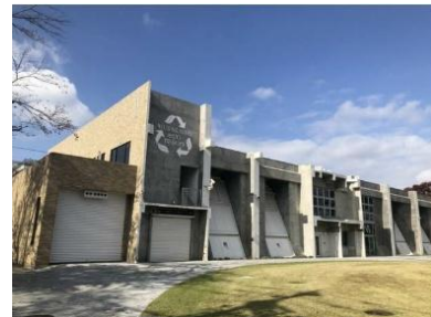
環境啓発施設 むさしのエコreゾート
