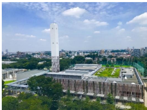
武蔵野クリーンセンター
