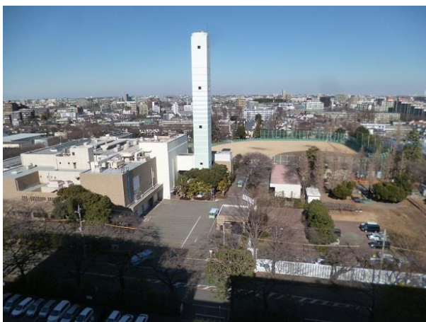
平成26年1月撮影（着工前）
