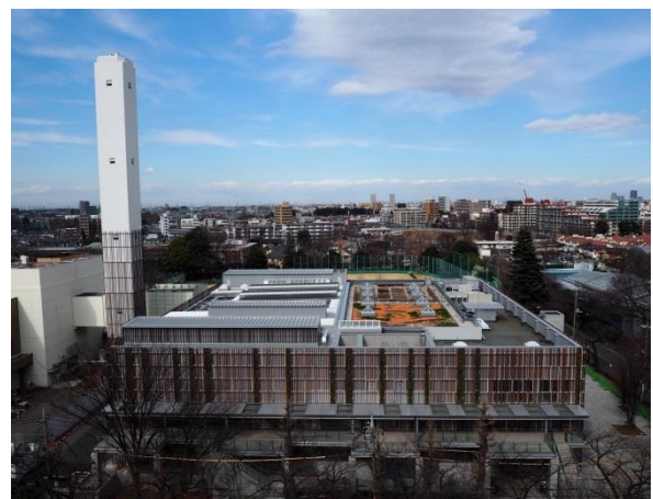
平成29年4月撮影（工場棟完成）
