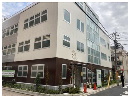
▲歩行者と自転車の動線が集中するエリアを回避した配置を行った吉祥寺クックロード自転車駐車場(武蔵野市)
