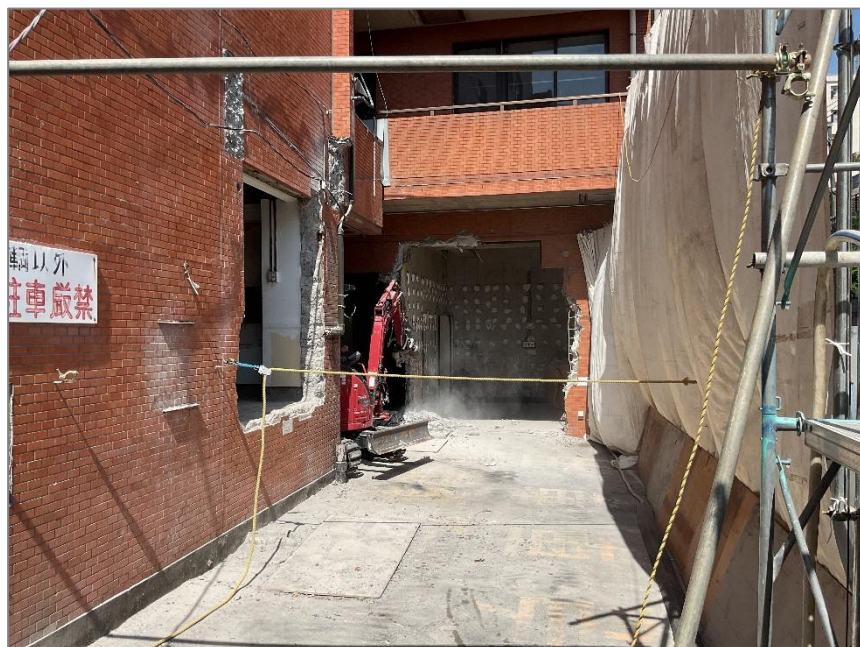
1階北側搬出口の解体の様子
