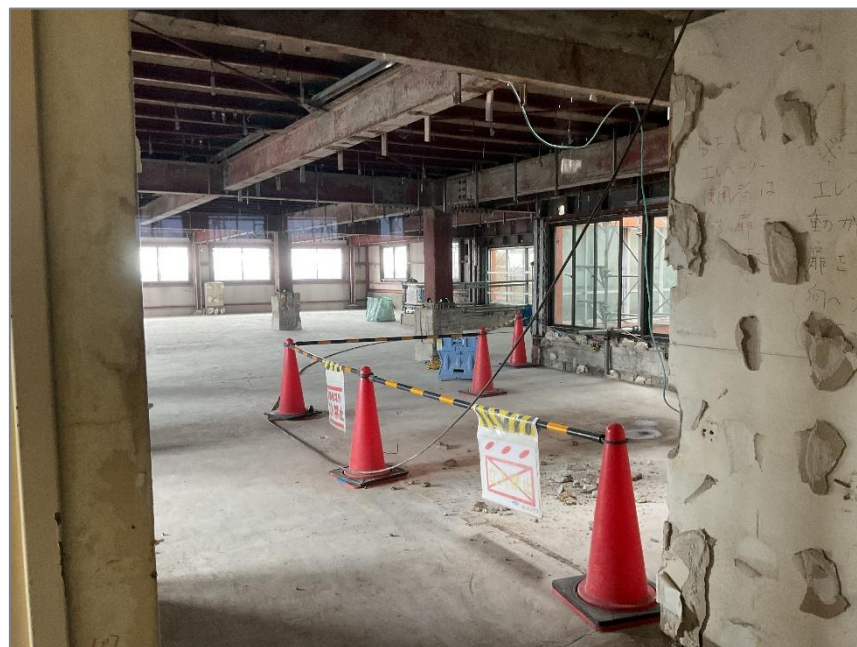
内装解体の様子
