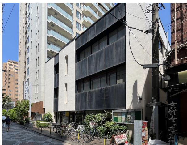
西側道路から北側方向
