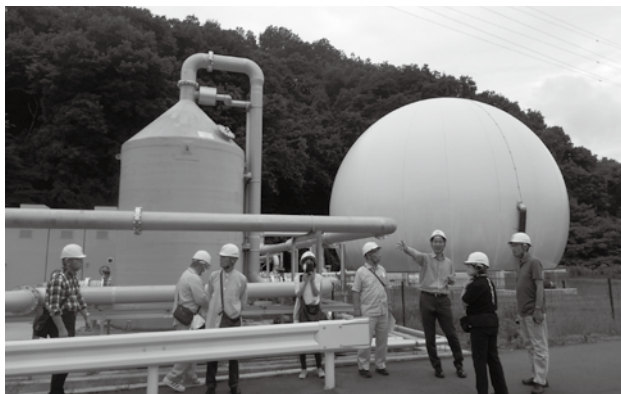
100tのバイオガス燃料を貯蔵しているガスホルダー(右)。 最大出力1,600kwの発電機(2基)へ送られます。
