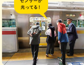
▲開閉扉は赤外線センサーで人の動きを検知して作動します
