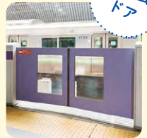
▲線路への転落を未然に防ぐために設置されたホームドア
