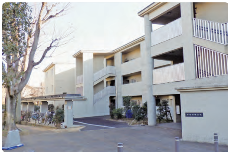
市営桜堤住宅
