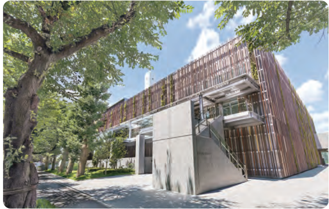
武蔵野クリーンセンター
