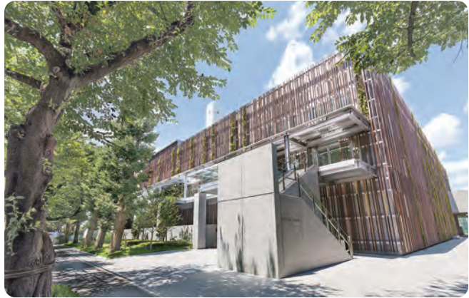
武蔵野クリーンセンター
