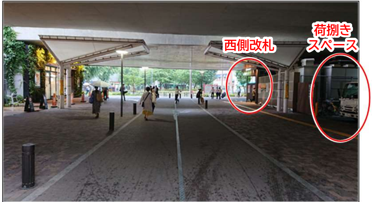
高架下区間を南側から撮影
