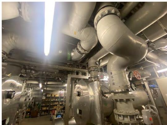
○武蔵野市立第四中学校の機械設備が更新設備機器の手前に設置されており、改修に時間を要すると想定される機械室（地下1階）
