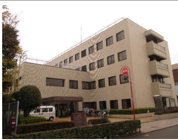
保健センター外観
