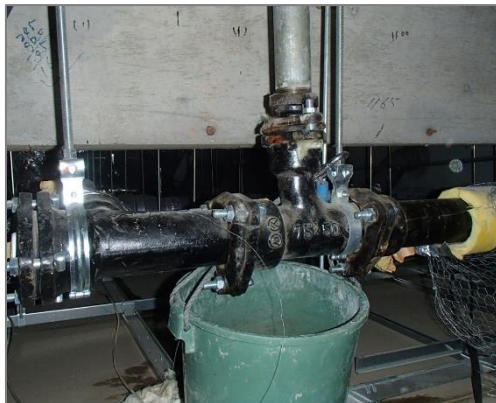
漏水発生時の排水管の状況
