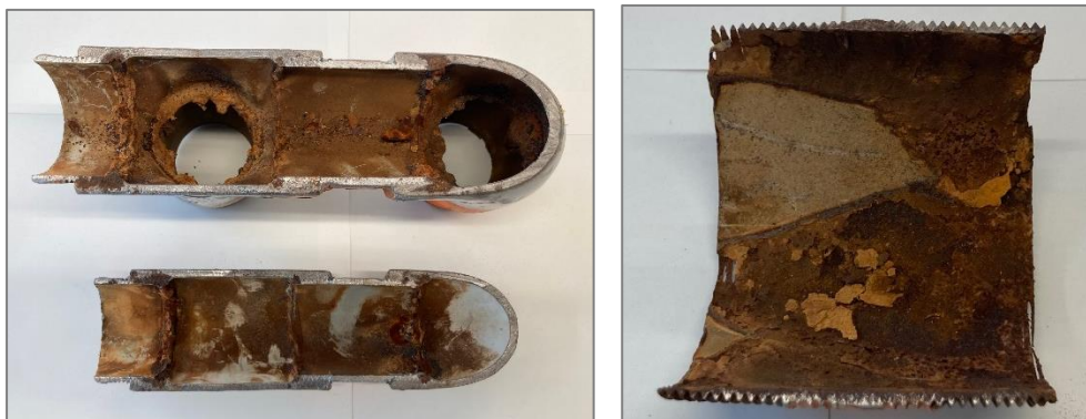
工事実施時の給水管の状況
