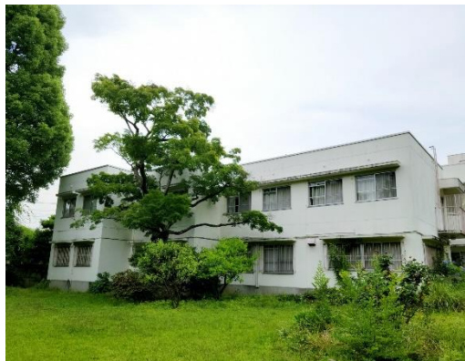
写真4 旧修室棟（外観）
