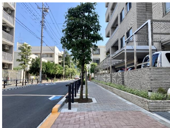
18 バリアフリーに配慮した市道第73号線
