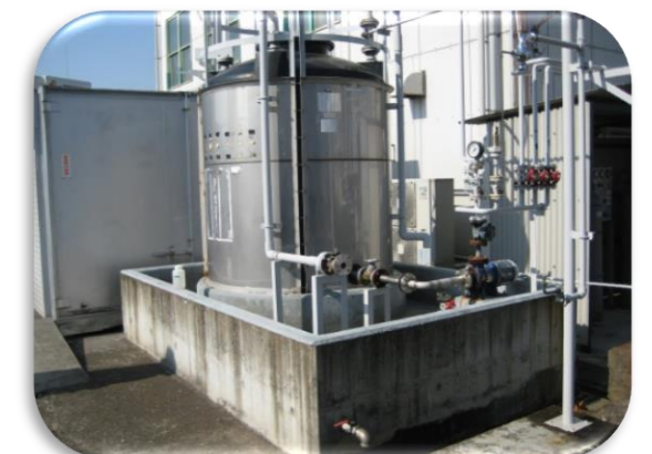
薬品タンクに防液堤を設置
