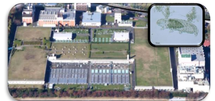
水再生センターと微生物(右上)
