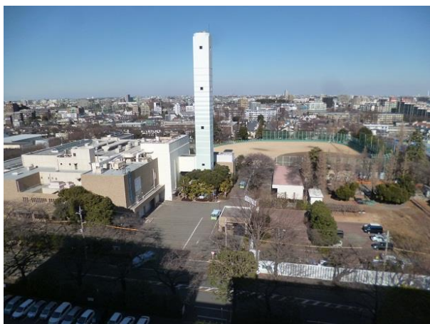
平成26年1月撮影（着工前）
