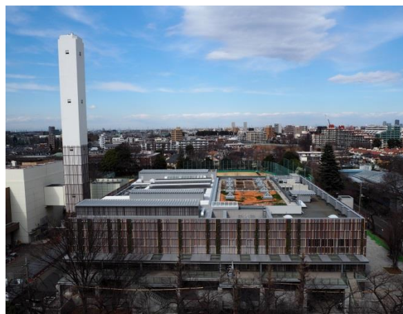
平成29年4月撮影（工場棟完成）
