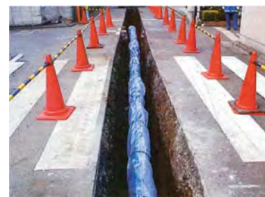
配水管更新工事の様子
