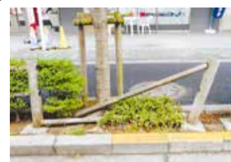
▲防護柵の破損
