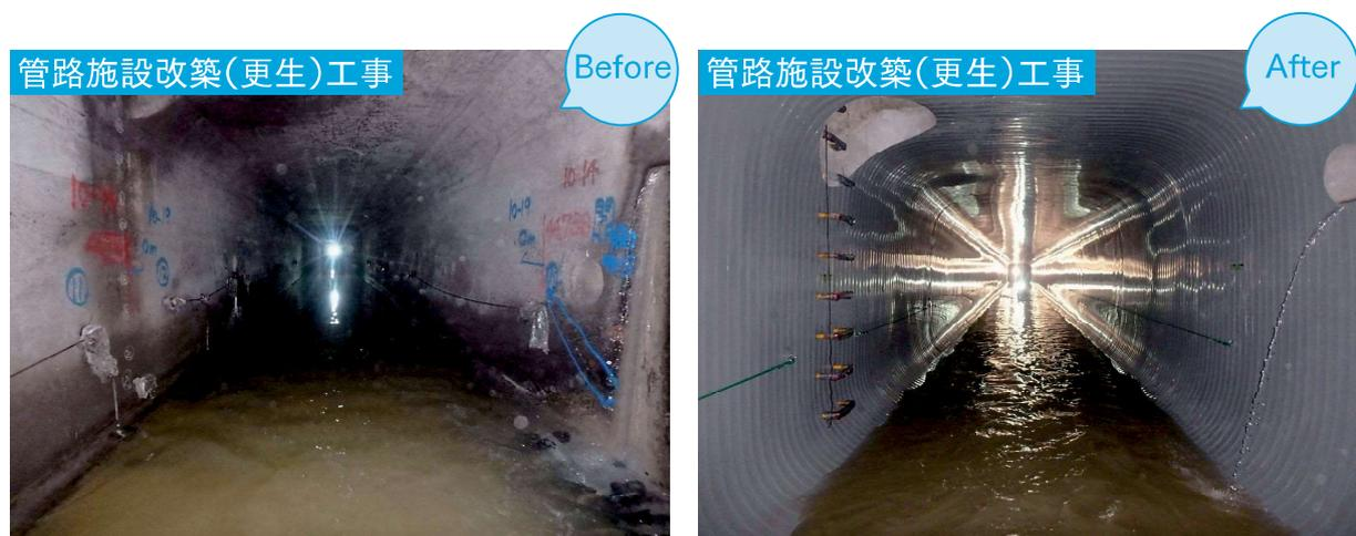
図3-33 女子大通り幹線管きよ更生工事の施工前後の状況
