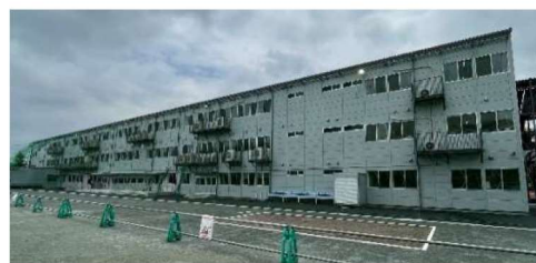
校庭側から見た仮設校舎
