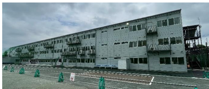
校庭側から見た仮設校舎
