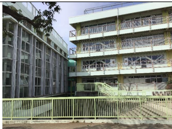
校舎棟・体育館棟接続部
