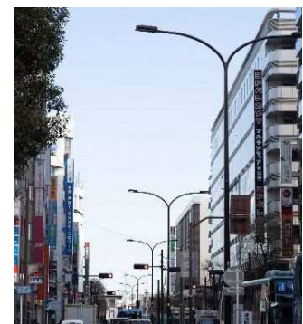
LED化後の大型街路灯 ▶
