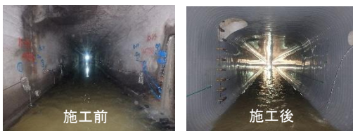
女子大通り幹線管きょ更生工事の施工前後の状況
