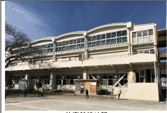
体育館棟外観
