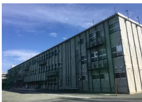
校庭側から見た仮設校舎
