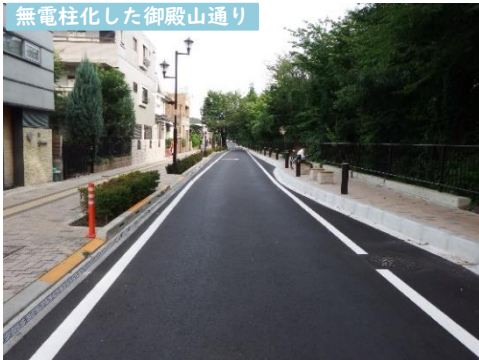
無電柱化した御殿山通り
