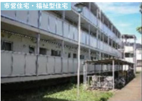
市営住宅・福祉型住宅
