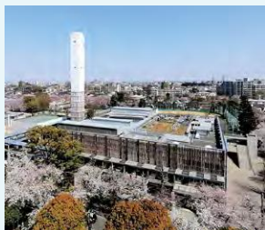
市民参加で建て替えを進めた クリーンセンター
