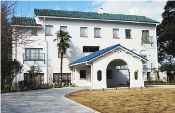
大規模改修後（令和2年）
