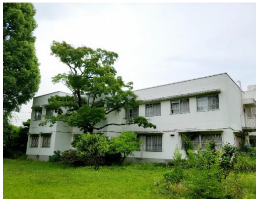
写真10 旧修室棟（外観）
