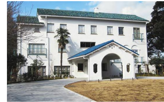
写真 11 神奈川県立スポーツセンター
