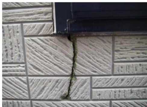
外壁サイディングのひび割れ・サッシ下
