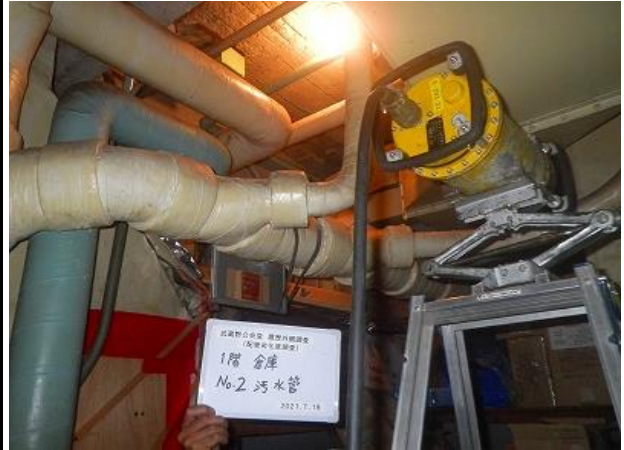
撮影状況写真
