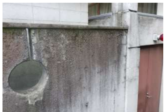
ホール棟1階 大道具搬入口 外壁塗装 78
