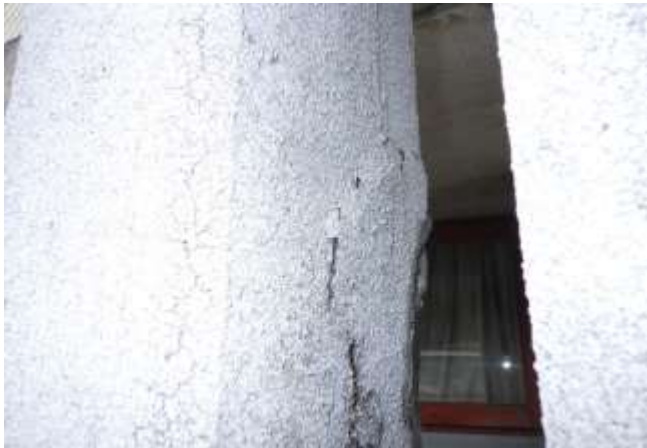
ホール棟1階 テラス(南) 73
