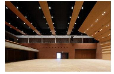
壁から上に開く天井反射板の事例。
