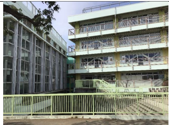
校舎棟・体育館棟接続部
