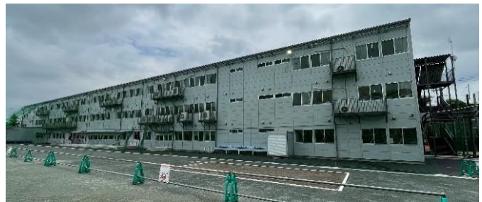
校庭側から見た仮設校舎
