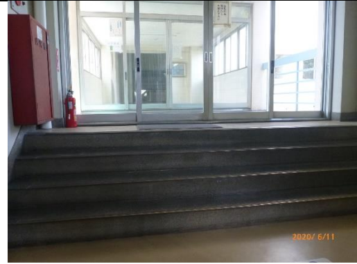
西校舎体育館棟接続部
