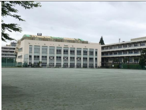
体育館棟遠景
