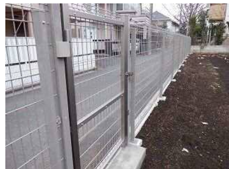
▲フェンスの設置
