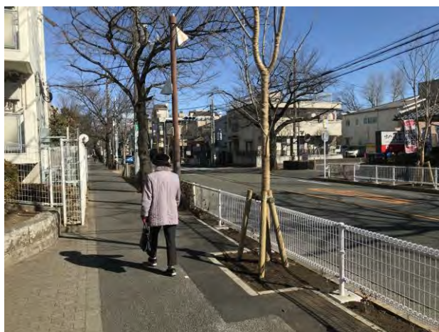
街路樹の根上がり対策（中央通り）
