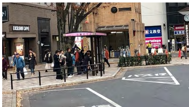
武蔵境駅南口のバスの正着に配慮したバス停留所
