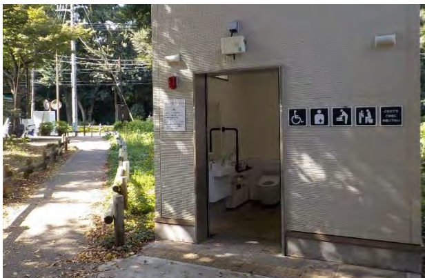
トイレの改修（都立井の頭恩賜公園）
