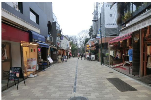
沿道店舗との段差解消に配慮した道路整備
