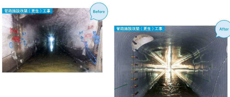
図 29 更生工事の様子
