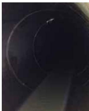
ふれあい下水道館では地下25mの下水道本管内部に入り、臭いや湿気を感じることができます。下水道は勾配をつけて汚水を運ぶ「自然流下方式」で作られています。汚水と雨水を同じ管で流す合流式下水道なので、豪雨の際に急激に水量が増える様子を映像で見ることができます。
