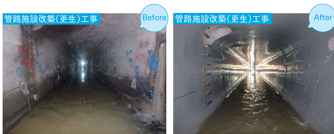
図3-33 女子大通り幹線管きょ更生工事の施工前後の状況
