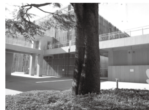
クリーンセンター 東北角の保存樹 (ヒマラヤスギ)
