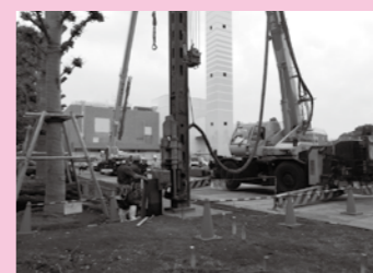
矢板を立てる杭打ち作業
