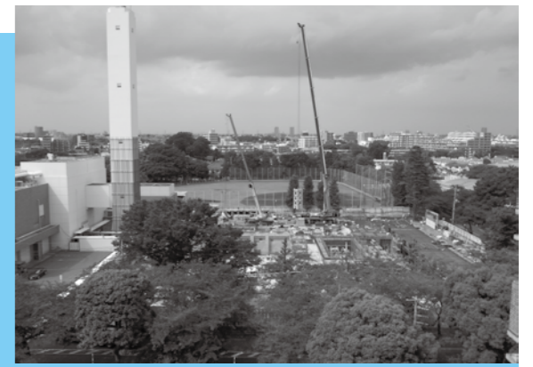
煙突のデザインが新しくなりました。緑が茂り、市役所の上階から工事部分が見えなくなりました。
