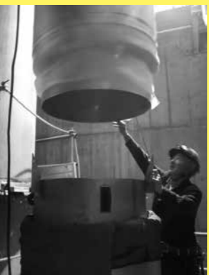
5月、2号炉の内筒は撤去され、新しい内筒をクレーンで入れました。外筒の中で作業員が慎重につなげて溶接していきます。
