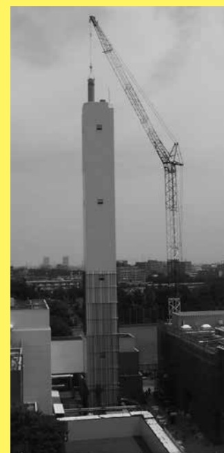
5月、2号炉の内筒は撤去され、新しい内筒をクレーンで入れました。外筒の中で作業員が慎重につなげて溶接していきます。
