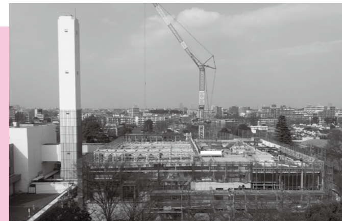
3月から3階の屋根部分の設置が始まりました。
