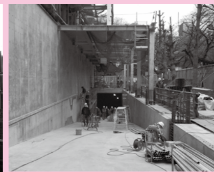
ごみ収集車が、地下のごみ投入ステージに入るスロープ。
